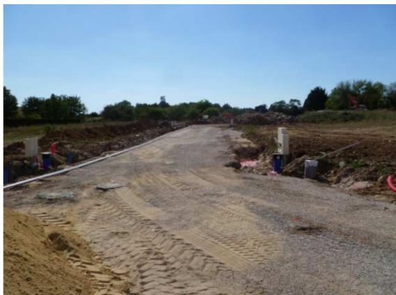
La mise en place des différents réseaux se poursuit tout à fait normalement malgré l'importance de la roche en sous-sol. Ainsi, les installations pour les eaux usées, les eaux pluviales, l'eau potable, le gaz, l'électricité, les télécommunications et l'éclairage public sont déjà enfouies.
